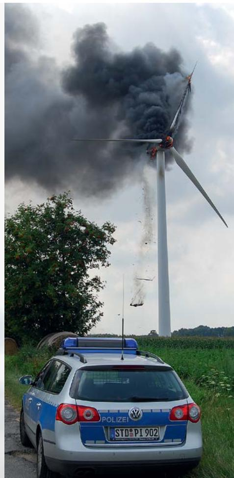
Die gleiche missliche Lage stellt sich dem Einsatzleiter bei der Erwägung eines Löschangriffes von außen dar. Bei 120 Meter Höhe muß der Maschinist mit mehr als 12 bar Druck fahren. Keine Pumpen und Schläuche sind dafür dauerhaft ausgelegt. So bleibt die Frage, wie das Löschwasser in solch eine Höhe kommen soll? Eine Drehleiter erreicht eine Höhe von etwa 30 Meter und damit nicht einmal ein Viertel der Turmhöhe.
